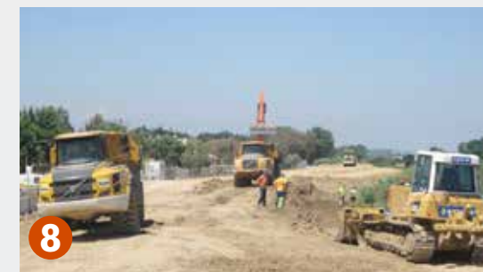
8 2013-2014 Confortement des digues du Lez sur le tronçon aval sur 1,5 km
