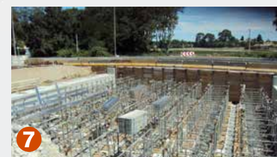
7 2010-2011 Ouvrages d'art de franchissement de la Lironde recalibrée par la RD21 et 21E
