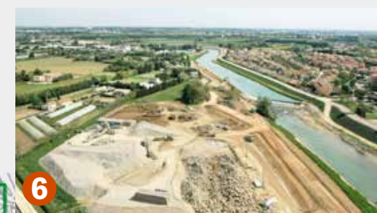
6 2009-2010 Confortement des digues du Lez sur 12 km
