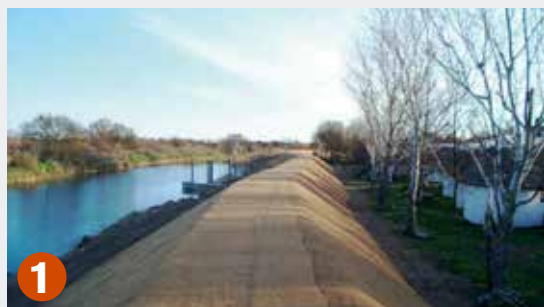
1 2006 Réparation de la digue rive gauche du Lez suite à la crue de septembre 2005
