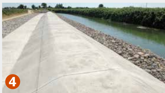
4 2007-2008 Création de l'ouvrage de dérivation des crues du Lez de 150 m de longueur (appelé partiteur de débit)
